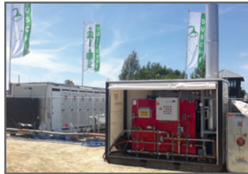
Mobile Heiß- und Brauchwarmwasserzentralen
