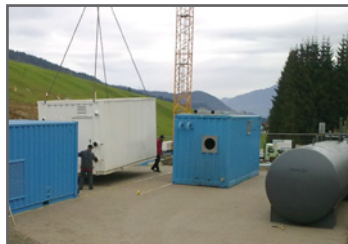
Mobile Biomasseheizzentralen
