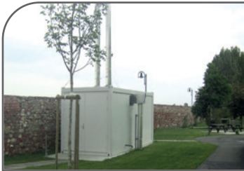
Mobile Heizzentralen im Container
